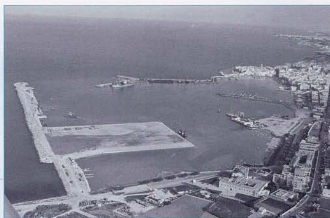
Molfetta. Lavori per la realizzazione del nuovo porto commerciale.
