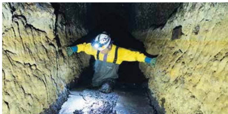
Il deposito di fango nel lato incile dopo il temporaneo abbassamento dell'acqua (Foto EGERIA CARLA GALEAZZI)
