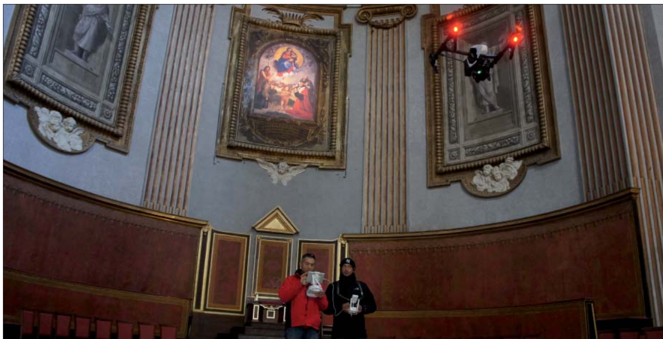
Figura 2 – (Mario Mazzoli – ASSO) Rilevamento dello stato di conservazione di alcuni particolari del Duomo di Foligno (PG) Survey to assess preservation of specific elements of the San Feliciano's Cathedral in Foligno (PG)
