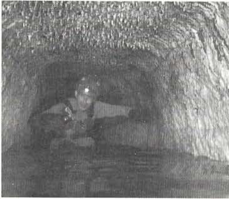
Il condotto verso valle, loc. Le Mole, oltre il primo pozzo (foto Archivio A.S.S.O., gentile concessione).
